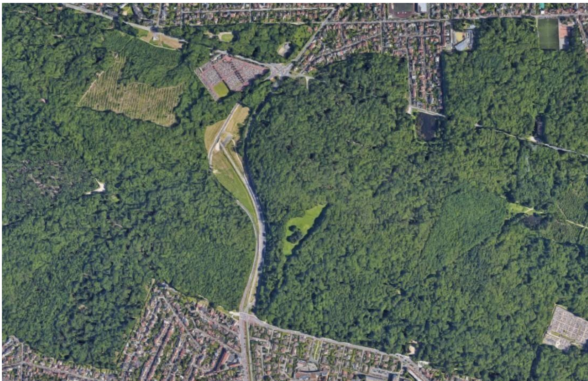
Fig. 1.2 : Vue aérienne de la forêt de Meudon à la sortie du tunnel du tramway T6 à Vélizy
