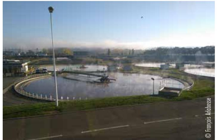
Les conséquences de son absence partielle sont principalement la dégradation du traitement du phosphore et une perte de capacité de précipitation des matières en suspension entraînant une limitation de la filière de biofiltration à  $13 \text{ m}^3/\text{s}$ . En cas de fortes pluies, cela entraînera donc des rejets nocifs dans la Seine et la destruction de nombreuses espèces vivantes.
