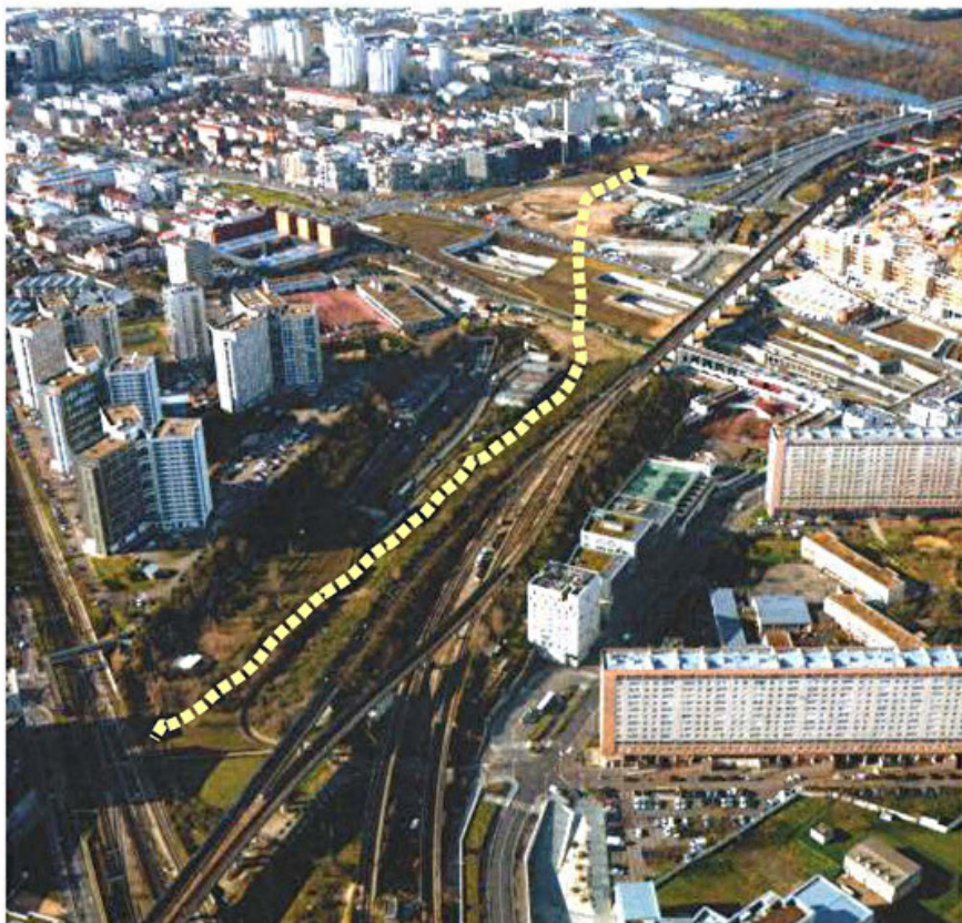
Position indicative de la coulée verte sur les toits de l'échangeur A14-A86
