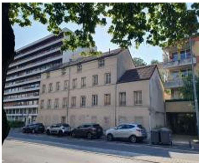
Bâtiment à démolir (Hauts de Seine Habitat) pour créer une zone humide végétalisée
