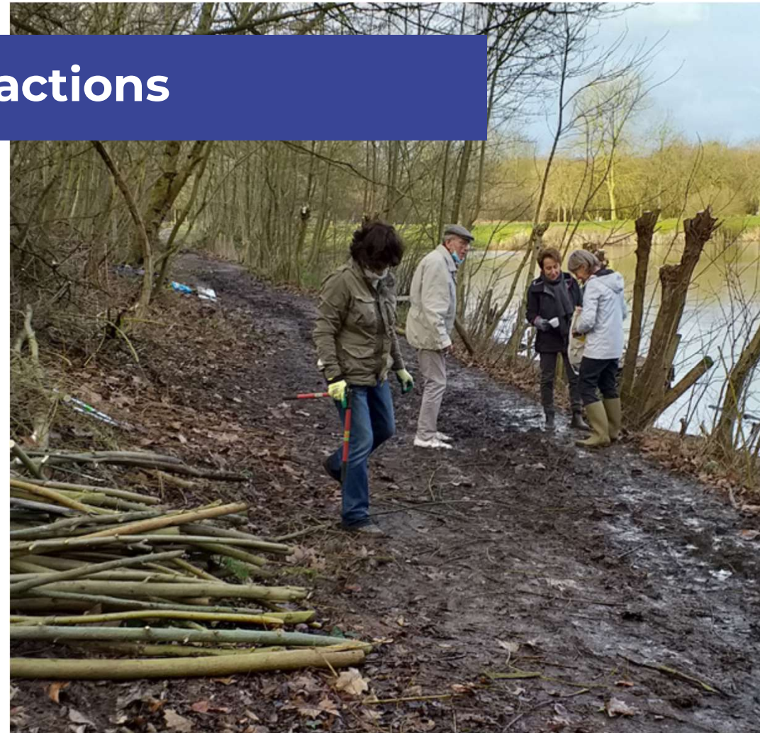
Installation de piquets chantier bénévole Vivent les étangs
